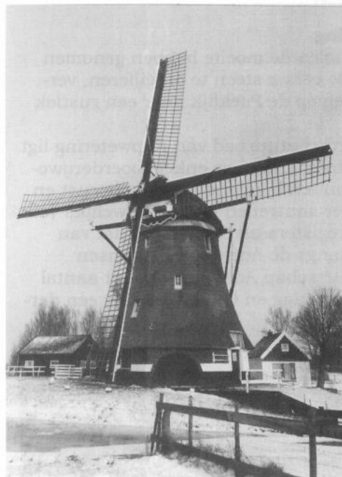
De Mopmolen. Zelfs in de winterdag staat de "Mop" met zijn Oud-Hollandse wiekvorm met een vlucht van 25,70 meter er zeer fraai bij.
